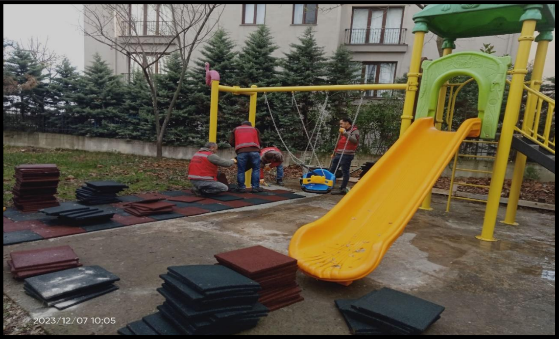
(Burunucu Mahallesi Orkide Sokak da bulunan ocuk parkının yeniden dzenlenmesi iři.)
