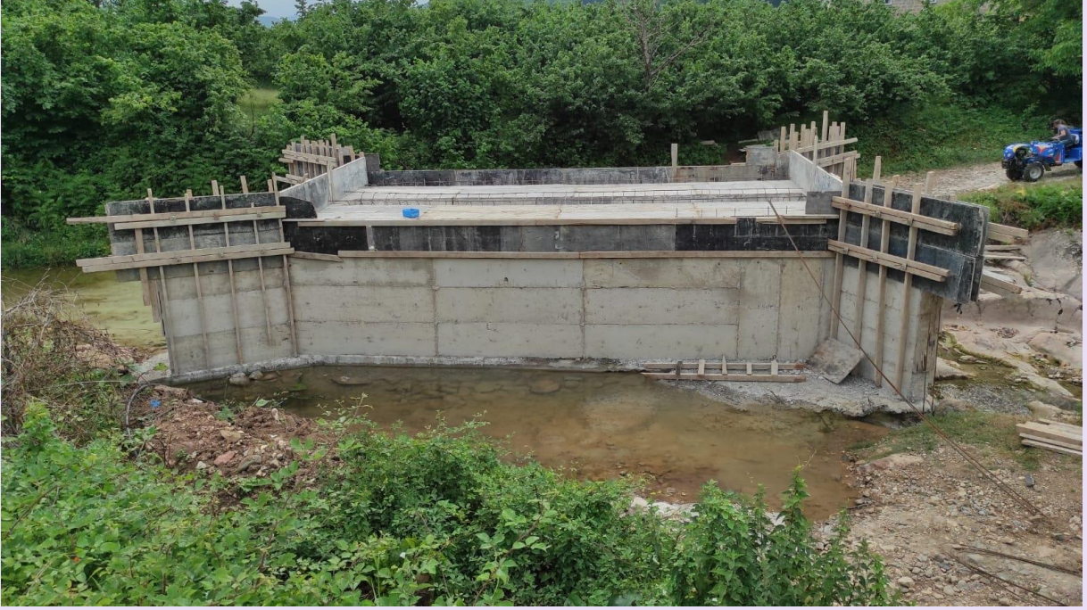
5. İlçemiz Cevzidere Mahallesinde yapımı tamamlanan ‘‘Yöresel Ürün Üretim Atölyesi ve Aşevinin’’ yolu ve istinad duvarı yapılarak hizmete açılmıştır.
