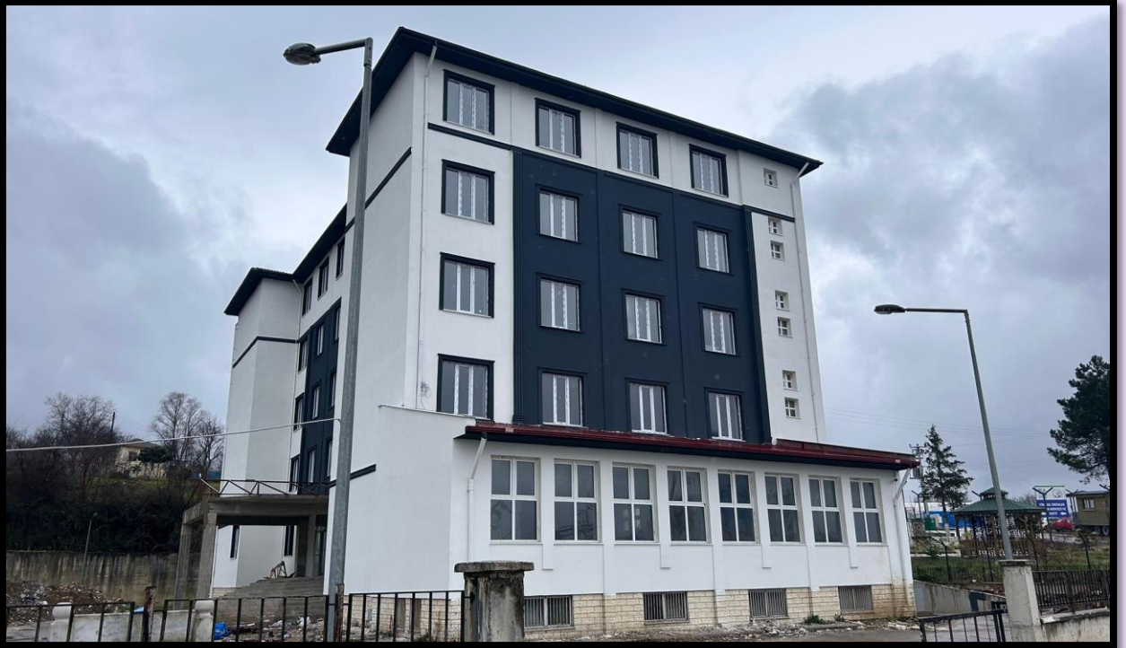
23) Öğretmenevi cephe çalışması
