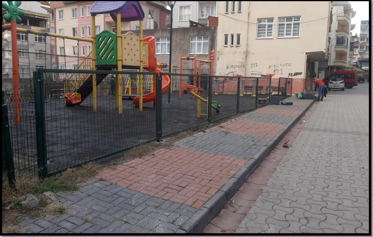
(Burunucu Mahallesi Çocuk Parkı Çevresi Tel Çit Yapımı)
