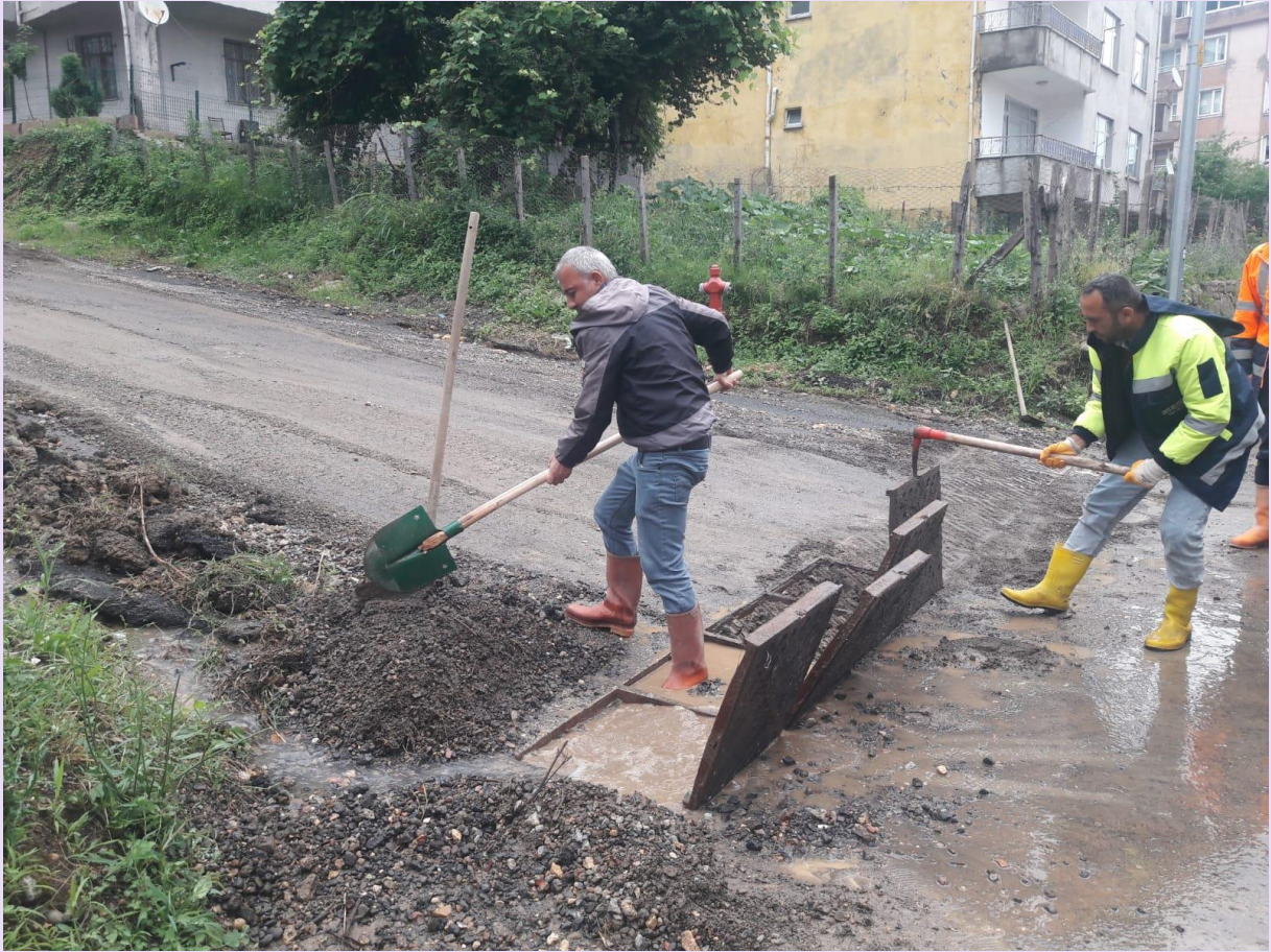
15. Şehiriçinde muhtelif mahallelerde yağmursuyu hatlarının ve ızgaraların rutin temizlikleri yapılmaktadır.
