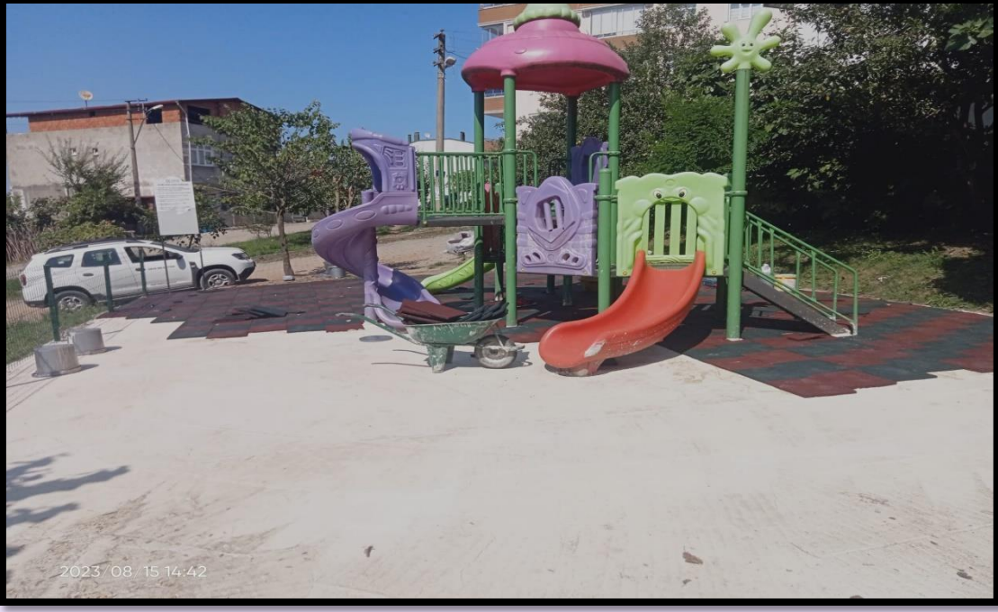
(Bayramca Mahallesi Tepe Sokak çocuk parkı tel çit yapımı, zemin beton dökümü ve kauçuk zemin yapımı)
