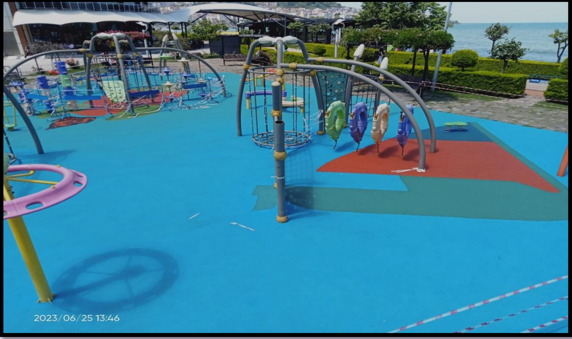
(Atatürk Parkı tartan zemin yapımı ve kafe önü kayrak taşı yapımı.)
