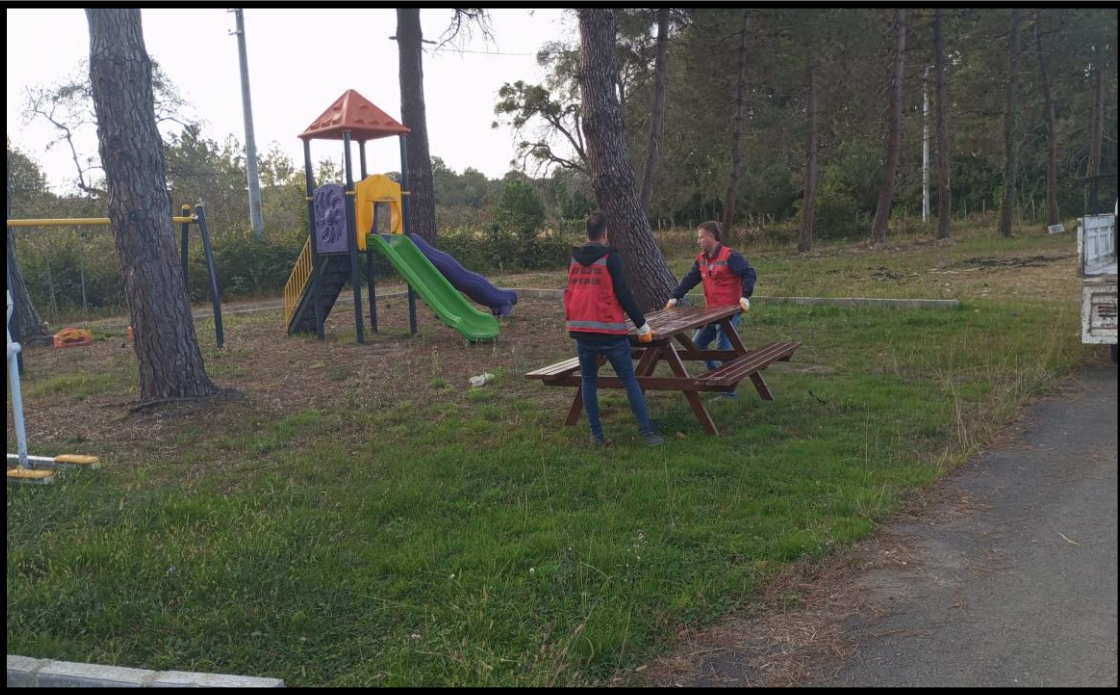
(Sahilköy Mahallesi Orman İşletme eğitim alanı çocuk parkı kurulumu)
